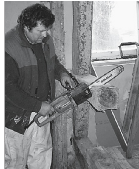
Bernd Karl bei Arbeiten im neuen Gemeindezentrum in Russow.
